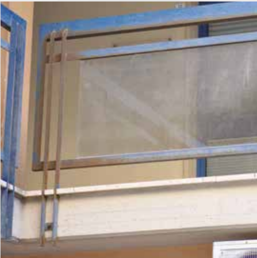
COSTRUZIONE DEGLI ANNI 80. BUILDING OF THE '80S
