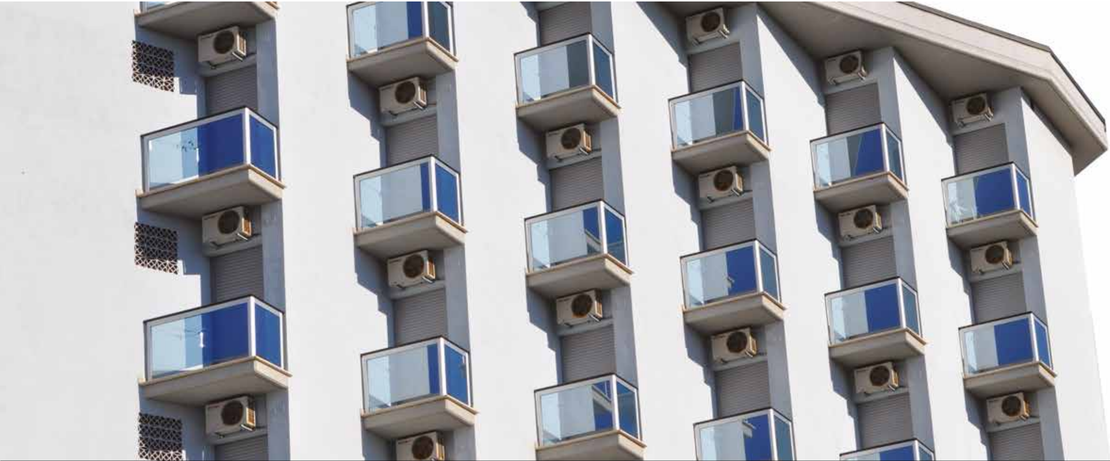
COSTRUZIONE DEGLI ANNI 60. BUILDING OF THE '60S
